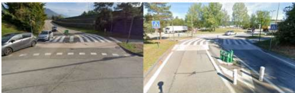
Réalisation d'un îlot refuge + plateau surélevé + marquage type résine colorée à Annecy
